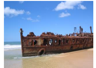
Formation de la rouille sur une épave marine
